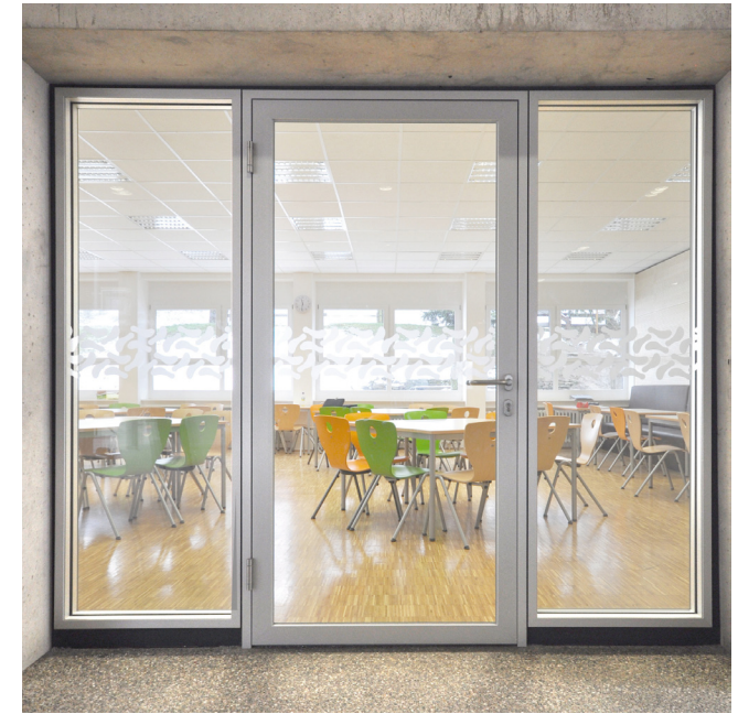
Blick in die multifunktional nutzbare Mensa im Bestand
